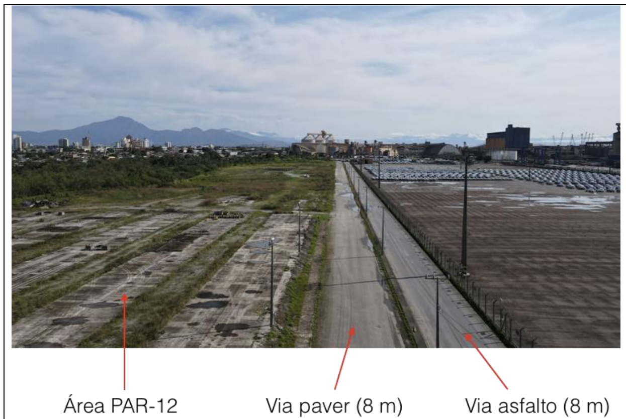
Figura 10. Área do Terminal de Veículos ASCENSUS e vias laterais de uso interno do Porto Organizado de Paranaguá.
