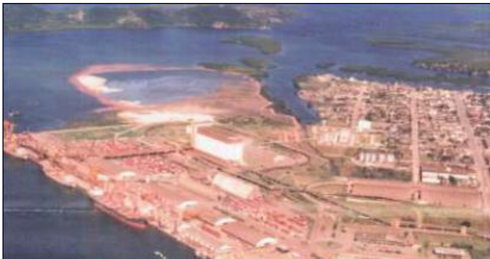
Figura 6. Obra do aterro hidráulico que originou a área de expansão portuária do Porto de Paranaguá. Fonte: APPA .
